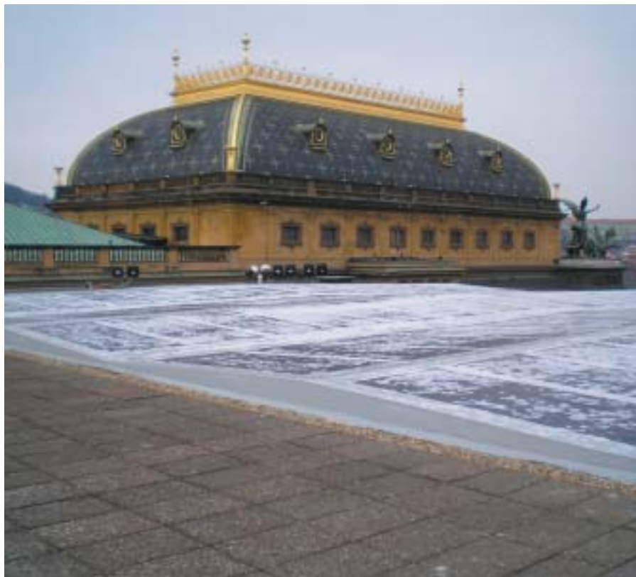
Fólie Evalon V-Solar 204 na střeše Provozní budovy Národního divadla
