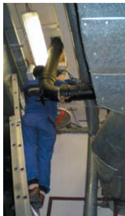
Montáž systému probíhala ve ztížených prostorových podmínkách
